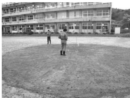
図2. 山木屋中学校における表土除去の様子
