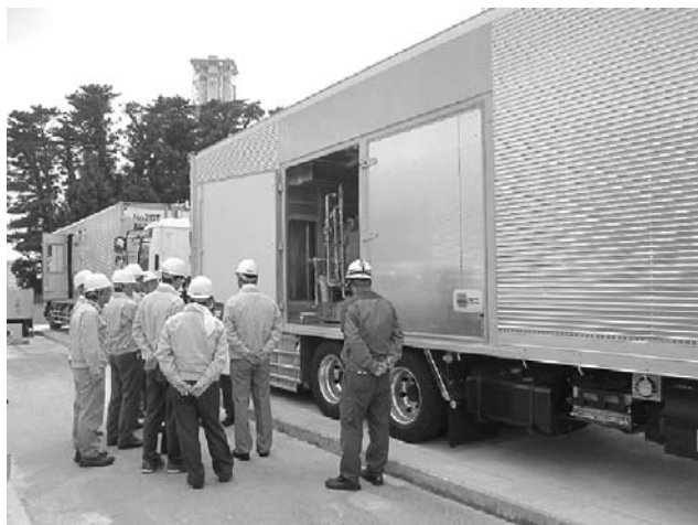
電源車 (ガスタービン発電機車)
